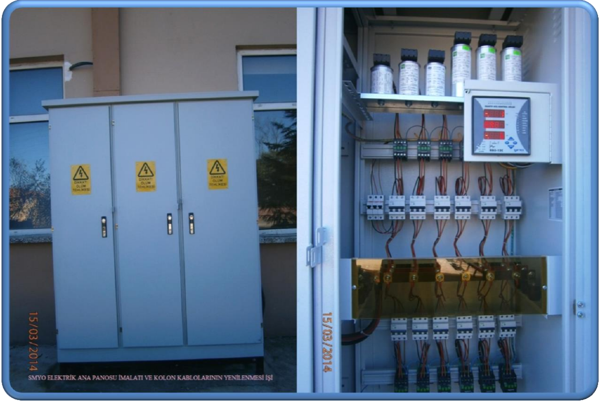
MESLEK YÜKSEKOKULU ELEKTRİK ANA PANOSU İMALATI VE KOLON KABLOLARININ YENİLENMESİ İŞİ
