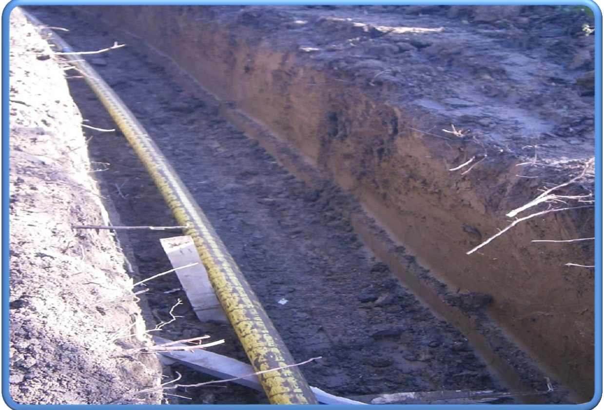
Kutlubey Kampüsü Doğal Gaz Ana Hattı, RMS-B İstasyonu, Gaz Dağıtım Hatları ve Servis Hatlarının Yapım İşi
