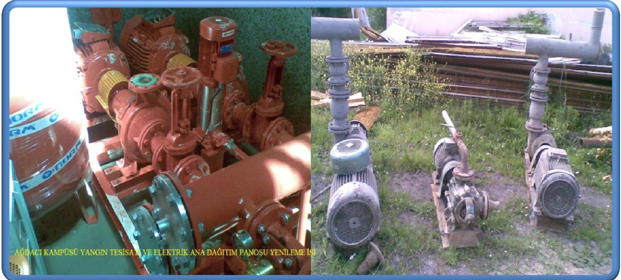
BARTIN ÜNİVERSİTESİ AĞDACI KAMPÜSÜ YANGIN TESİSATI VE ELEKTRİK ANA DAĞITIM PANOSU YENİLEME İŞİ
