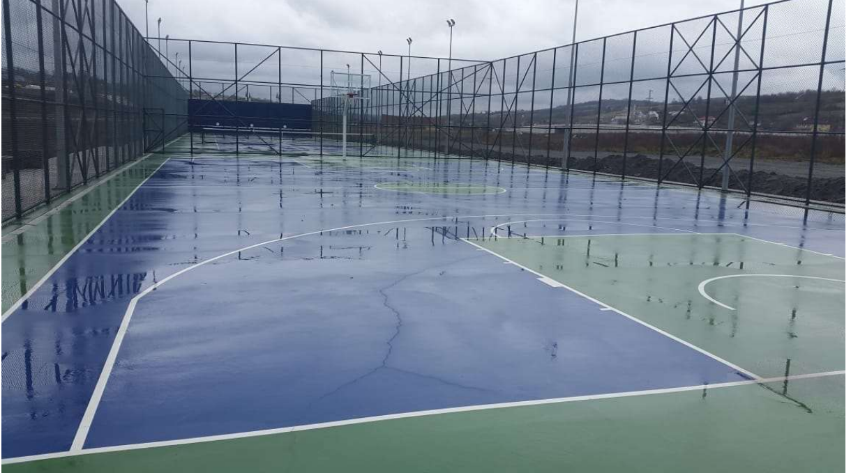
Resim 5. Basketbol Sahası (Açık Spor Alanı)
