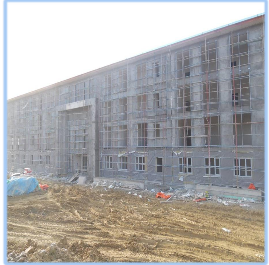
Mühendislik Fakültesi İdari Bina Genel Görünüş
