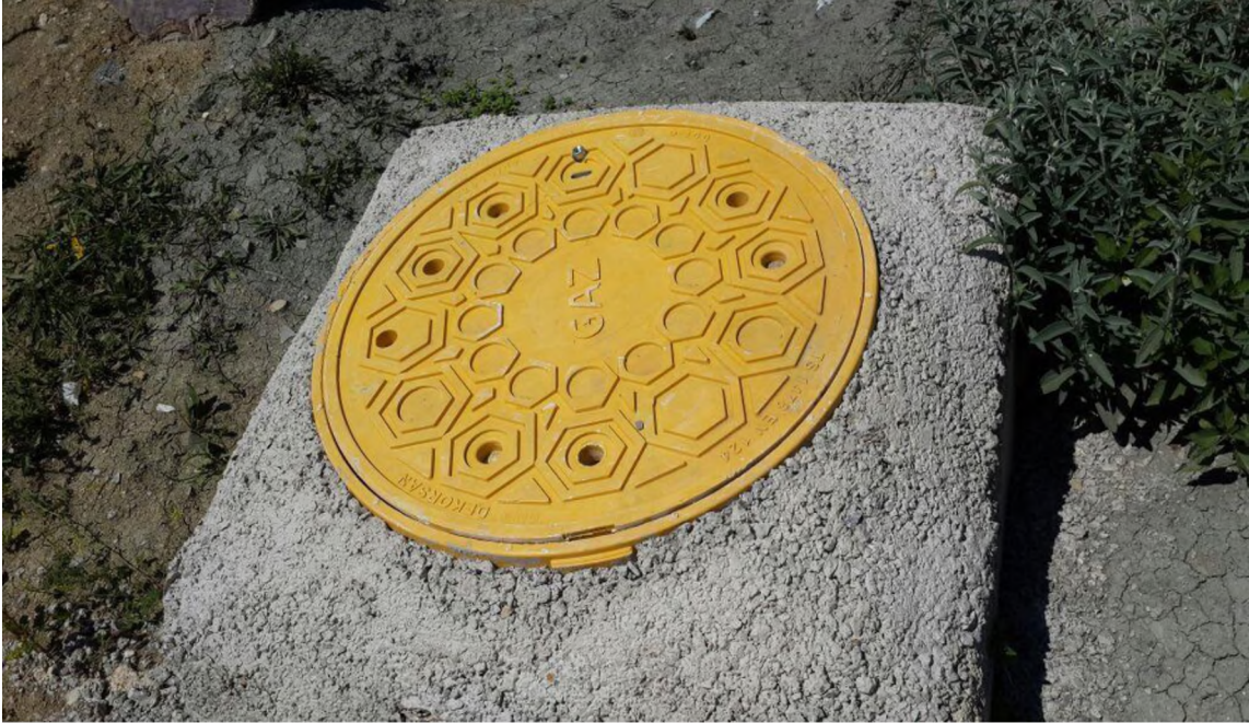
Kutlubey Kampüsü Doğal Gaz Ana Hattı, RMS-B İstasyonu, Gaz Dağıtım Hatları ve Servis Hatlarının Yapım İşi
