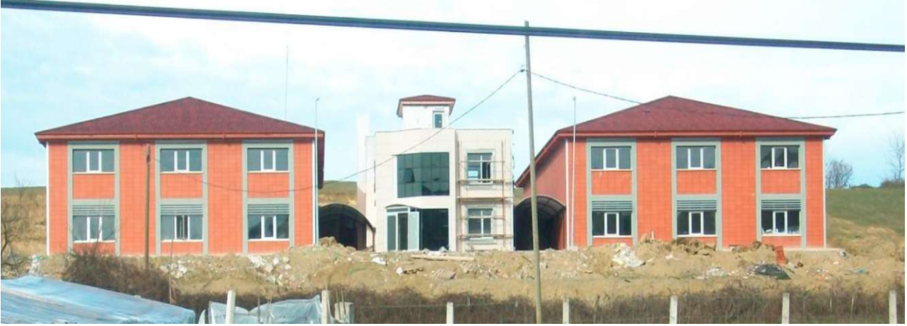
Merkezi Laboratuvar Binası Yapım İşi
