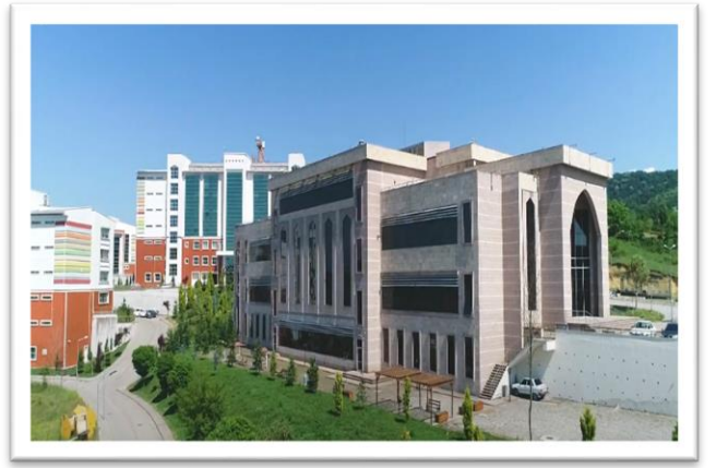
Sayısal Derslik Binası
