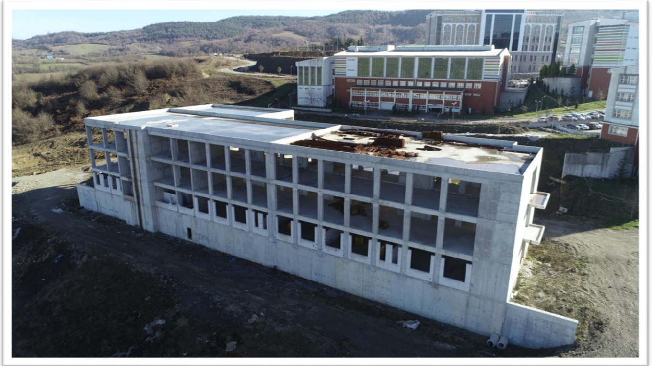
Yeni Laboratuvar Binası
