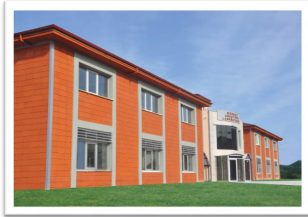
Merkezi Araştırma Laboratuvar Binası
