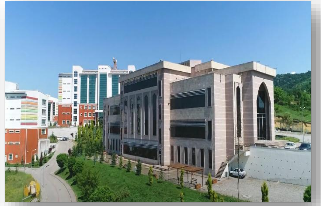
Sayısal Derslik Binası
