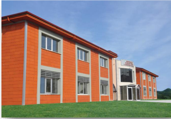
Merkezi Araştırma Laboratuvar Binası
