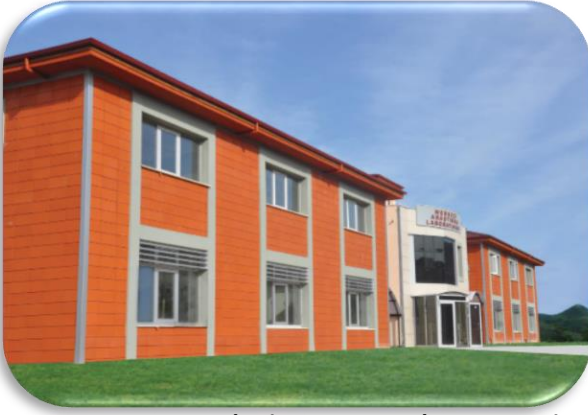
Merkezi Araştırma Laboratuvar Binası
