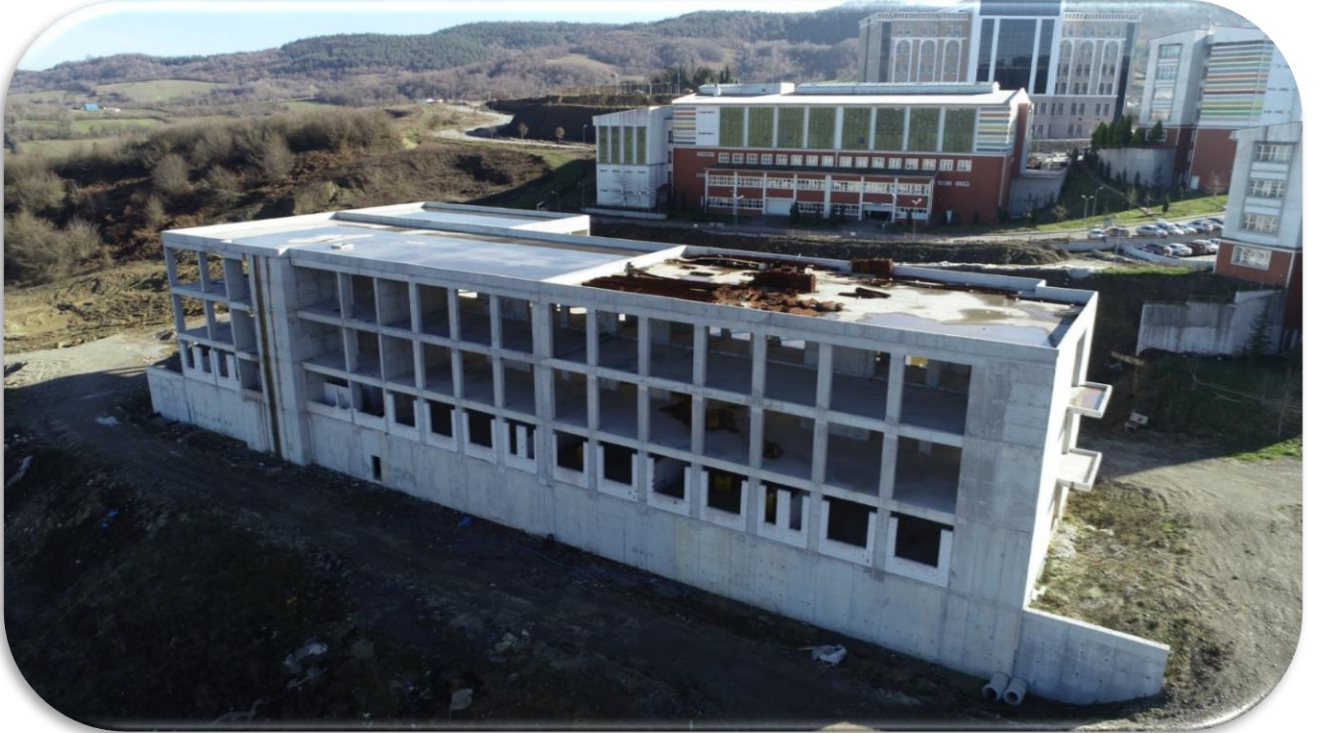
Yeni Laboratuvar Binası
