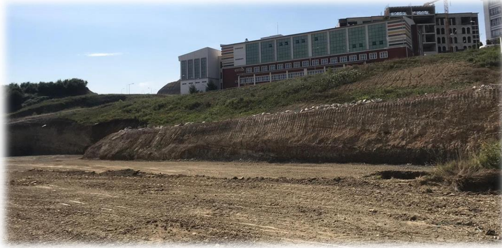
Laboratuvar Binası İnşa Alanı
