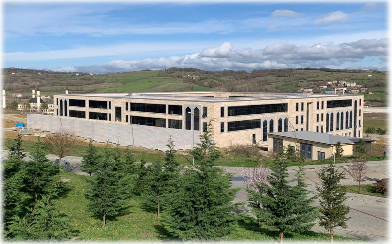
Merkezi Derslik Binası
