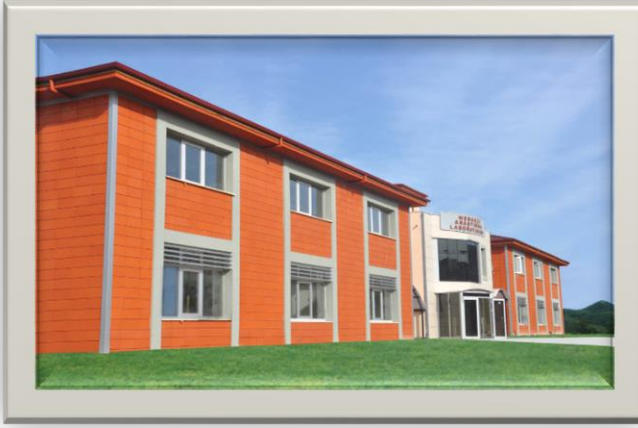
Merkezi Araştırma Laboratuvar Binası
