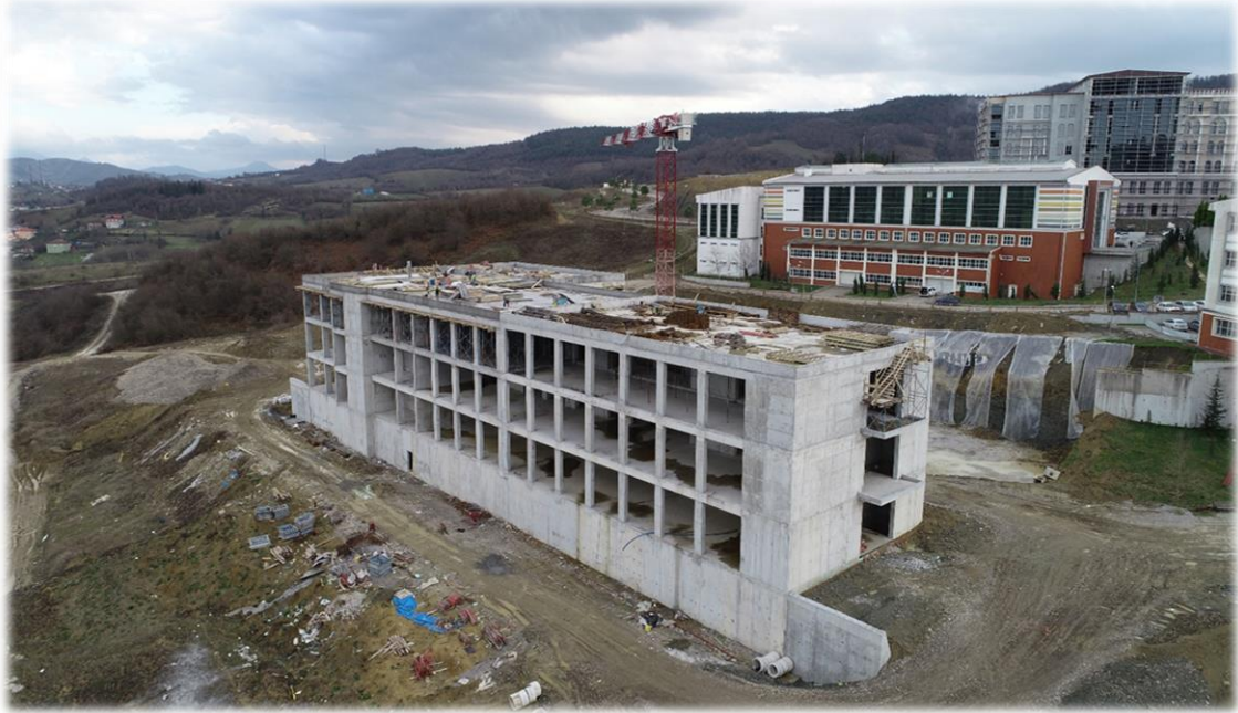
Laboratuvar Binası Yapım İşi
