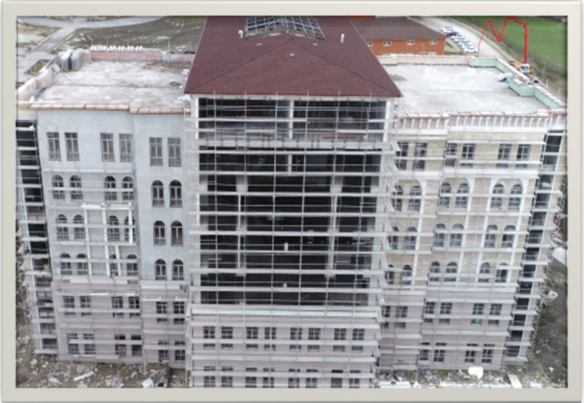
Rektörlük Binası Yapım İşi
