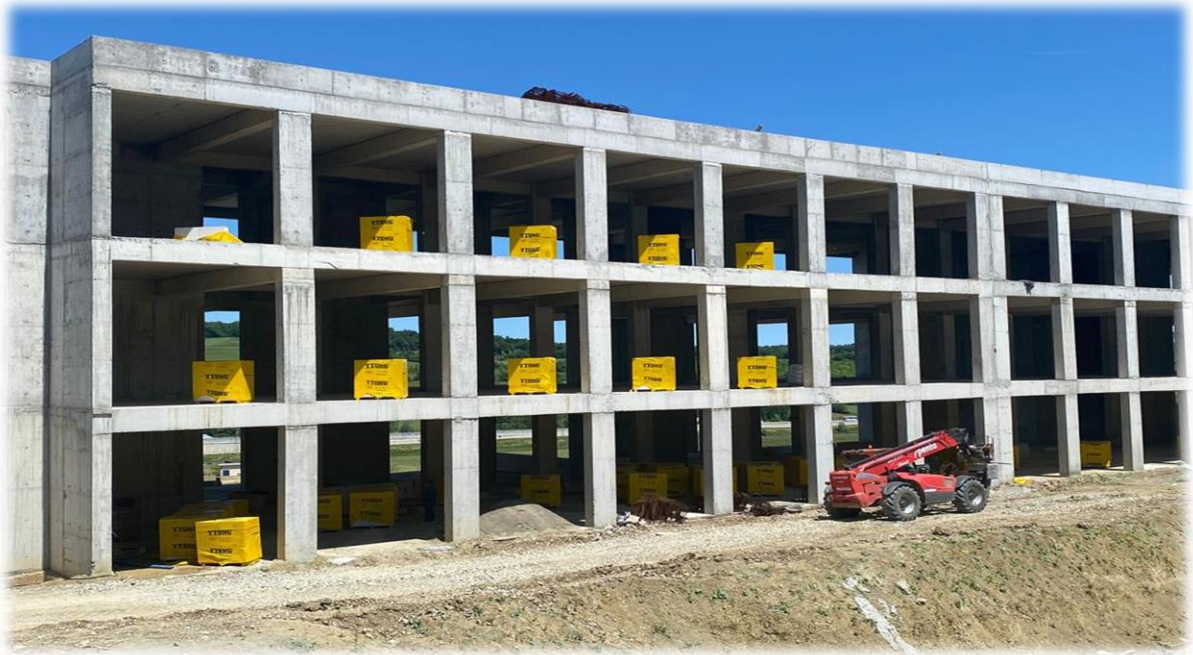
Laboratuvar Binası Yapım İşi
