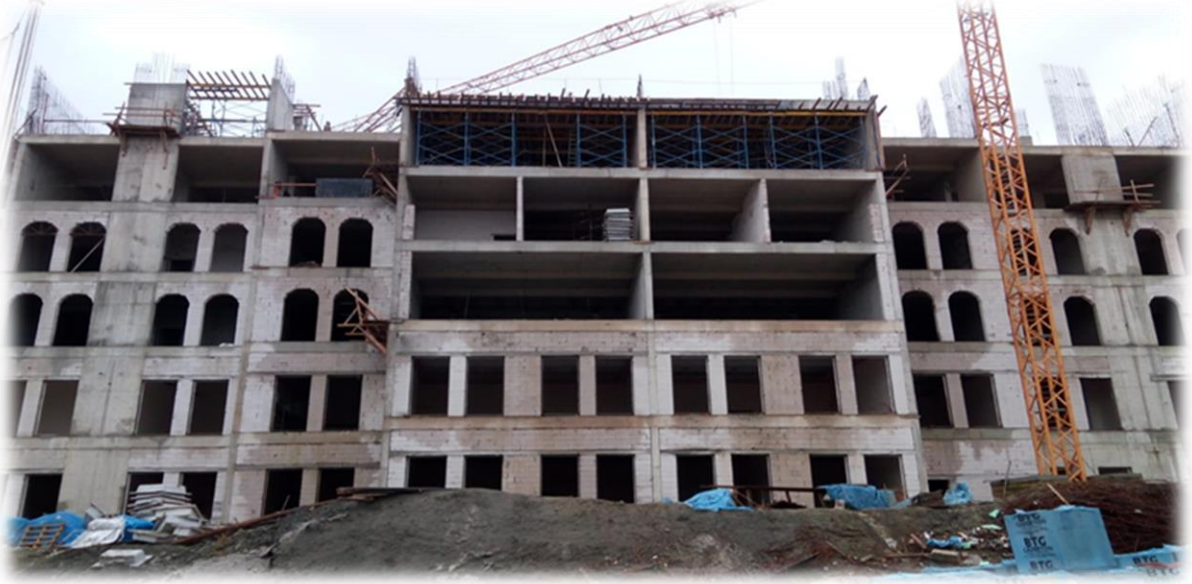
Rektörlük Binası Yapım İşi
