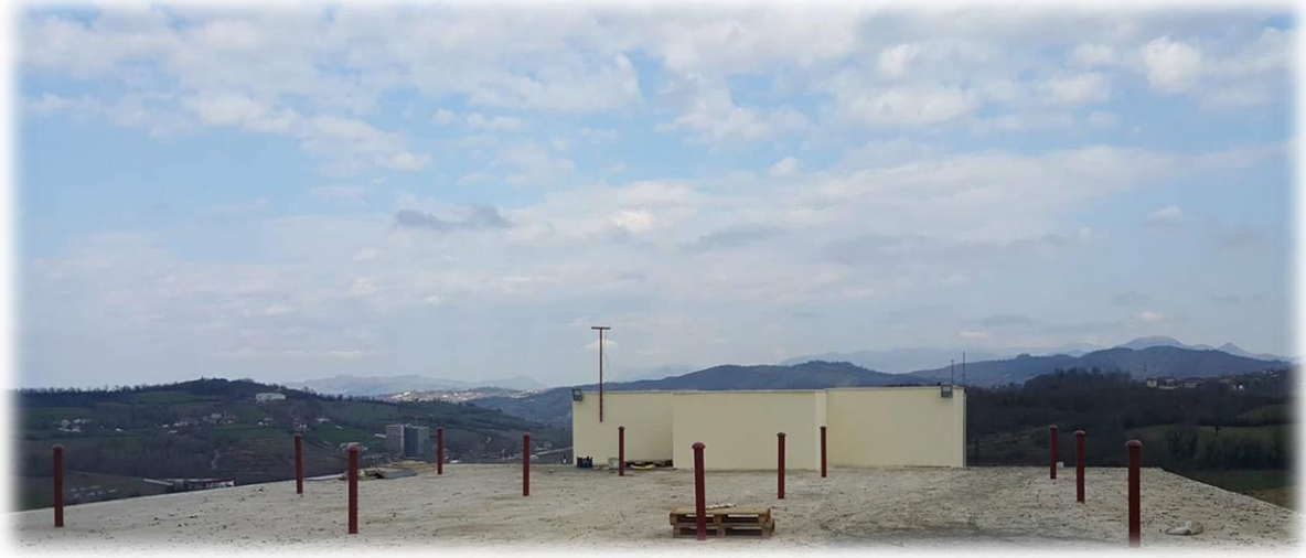
Kutlubey Kampüsü Su Deposu Yapım İşleri
