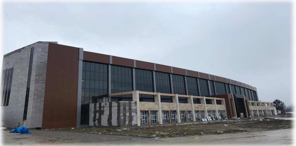
Kütüphane Binası Yapım İşi
