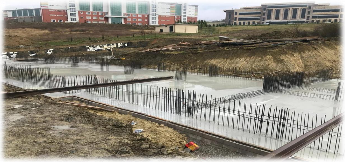
Derslik Binası Yapım İşi
