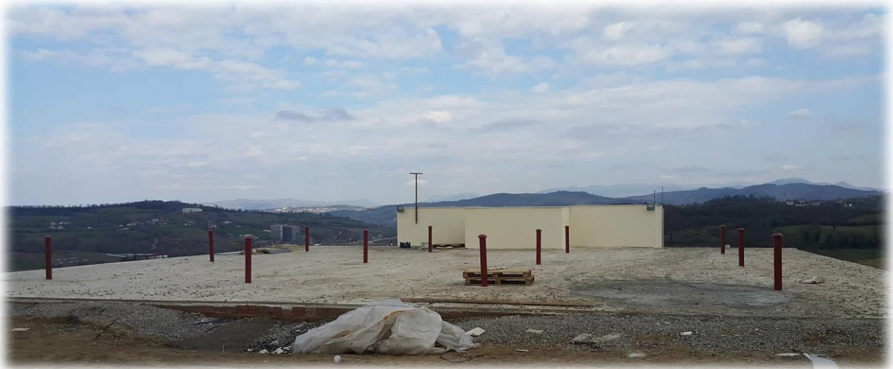
Kutlubey Kampüsü Su Deposu
