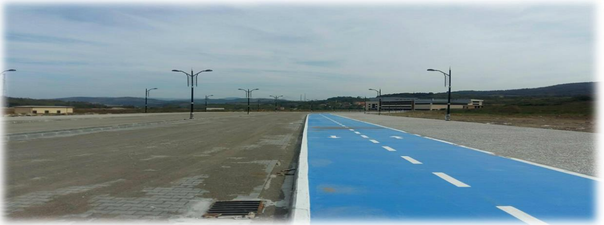
Kutlubey Kampüsü Giriş Kapısından BESYO Binasına Yol Yapım İşi
