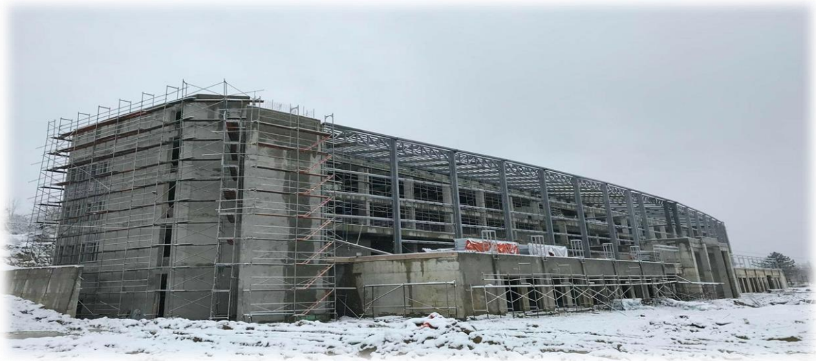
Kütüphane Binası Yapım İşi
