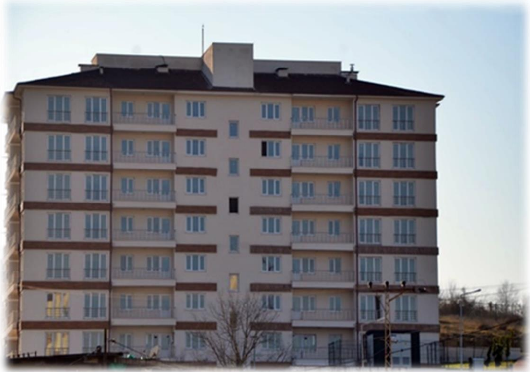
Lojman Binası ve Altyapı Yapım İşi
