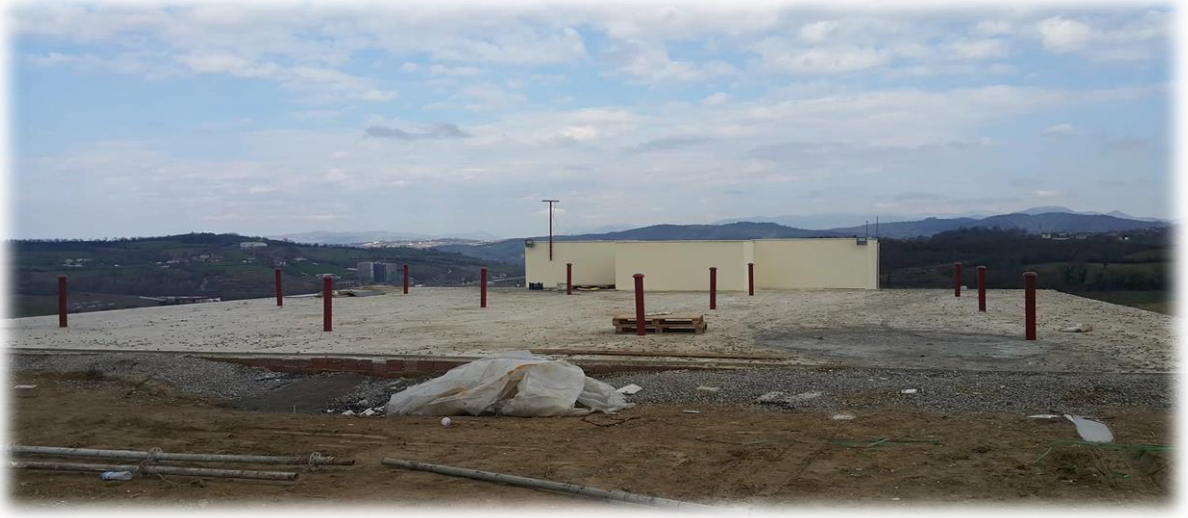
Kutlubey Kampüsü Su Deposu Yapım İşi
