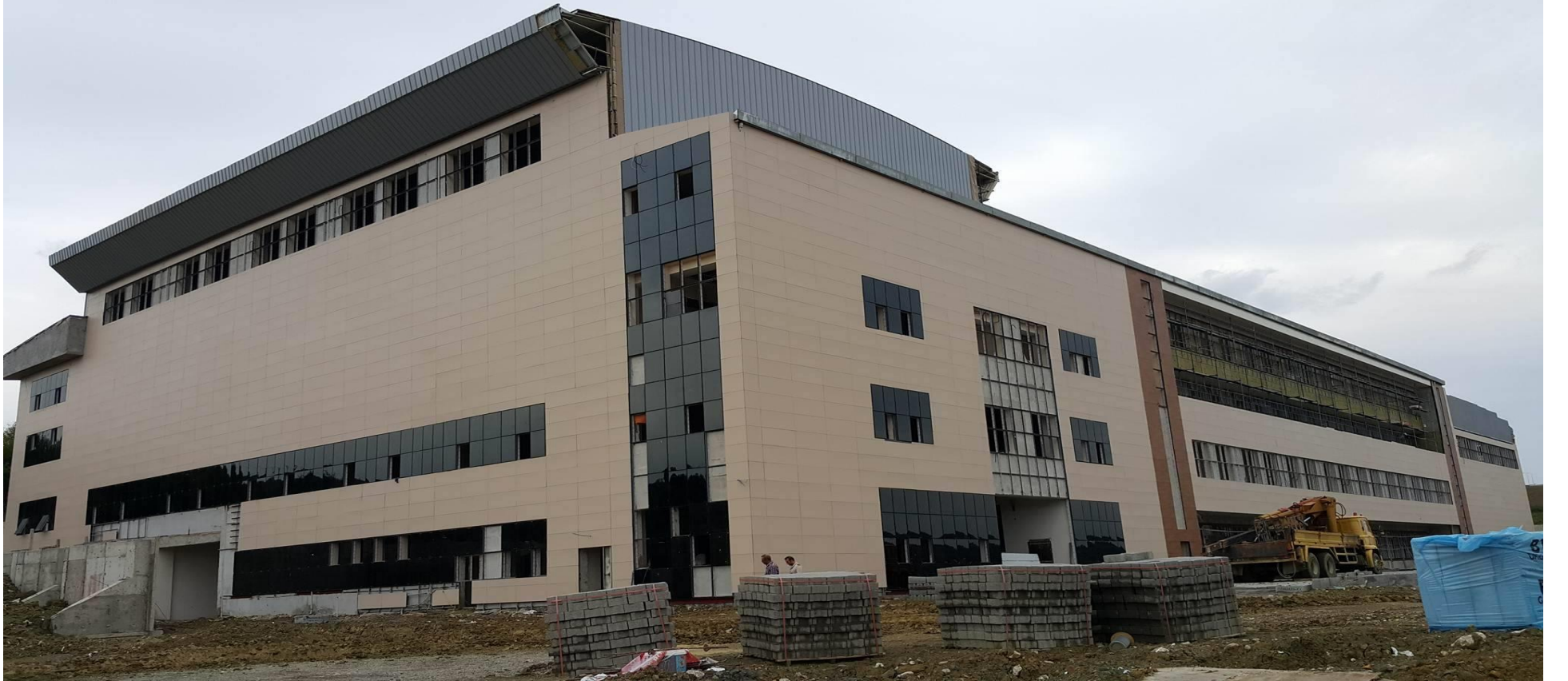
Kapalı Spor Salonu ve Beden Eğitimi ve Spor Yüksekokulu Binası Genel Görünüm
