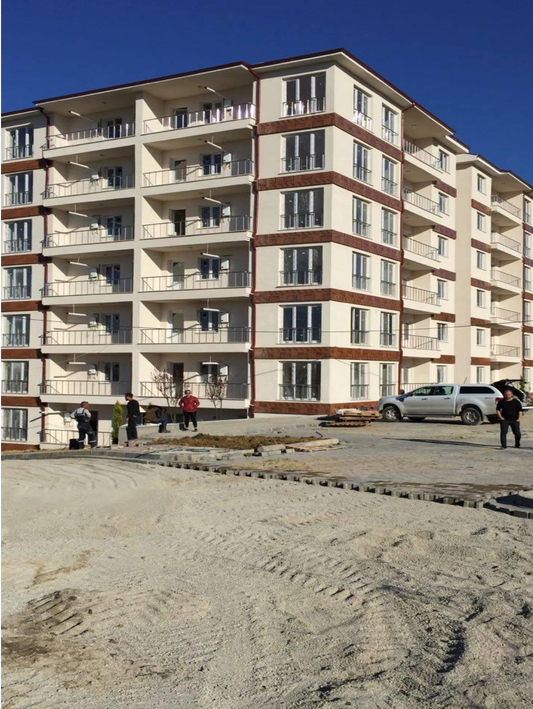
Lojman Binası Genel Görünüm
