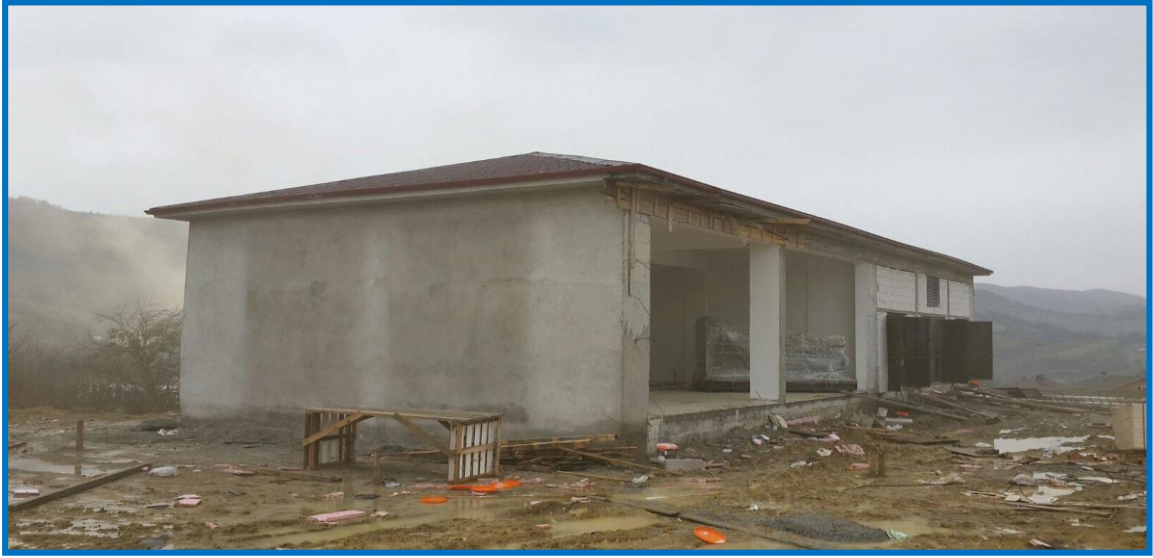
3 No'lu Trafo Binası ve Elektrik Hattı Yapım İşi
