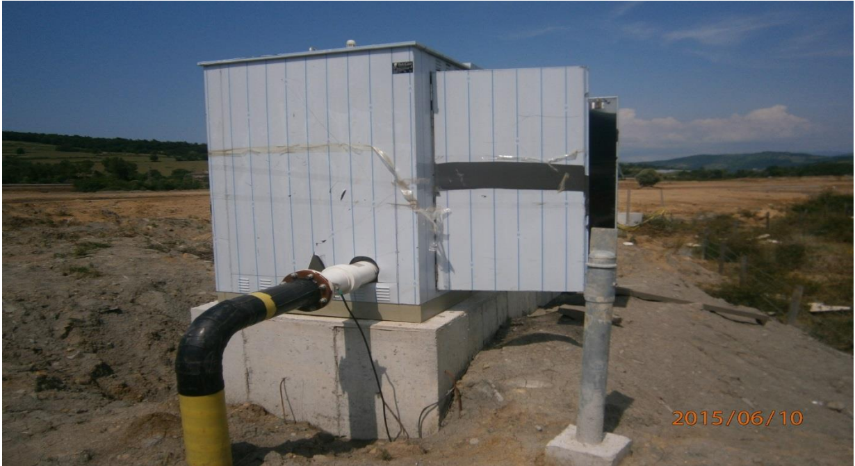
Kutlubey Kampüsü Doğal Gaz Ana Hattı, RMS-B İstasyonu, Gaz Dağıtım Hatları ve Servis Hatlarının Yapım İşi
