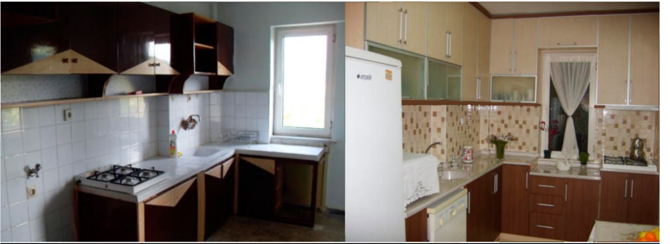
24 Dairelik Lojmanların Bakım Onarım İşi
