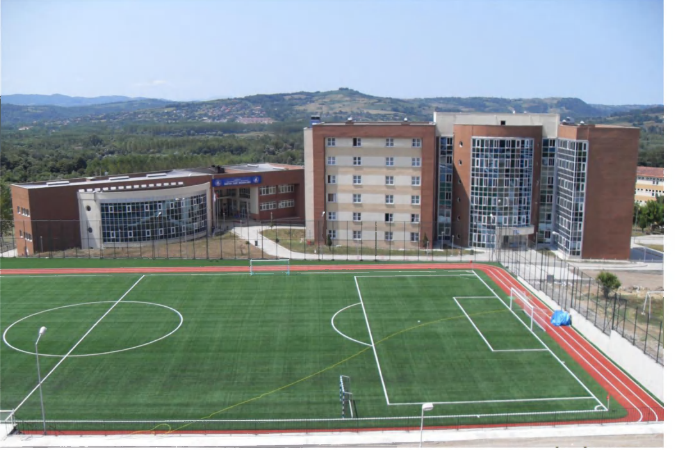
Sentetik Çim Saha Yapım İşi
