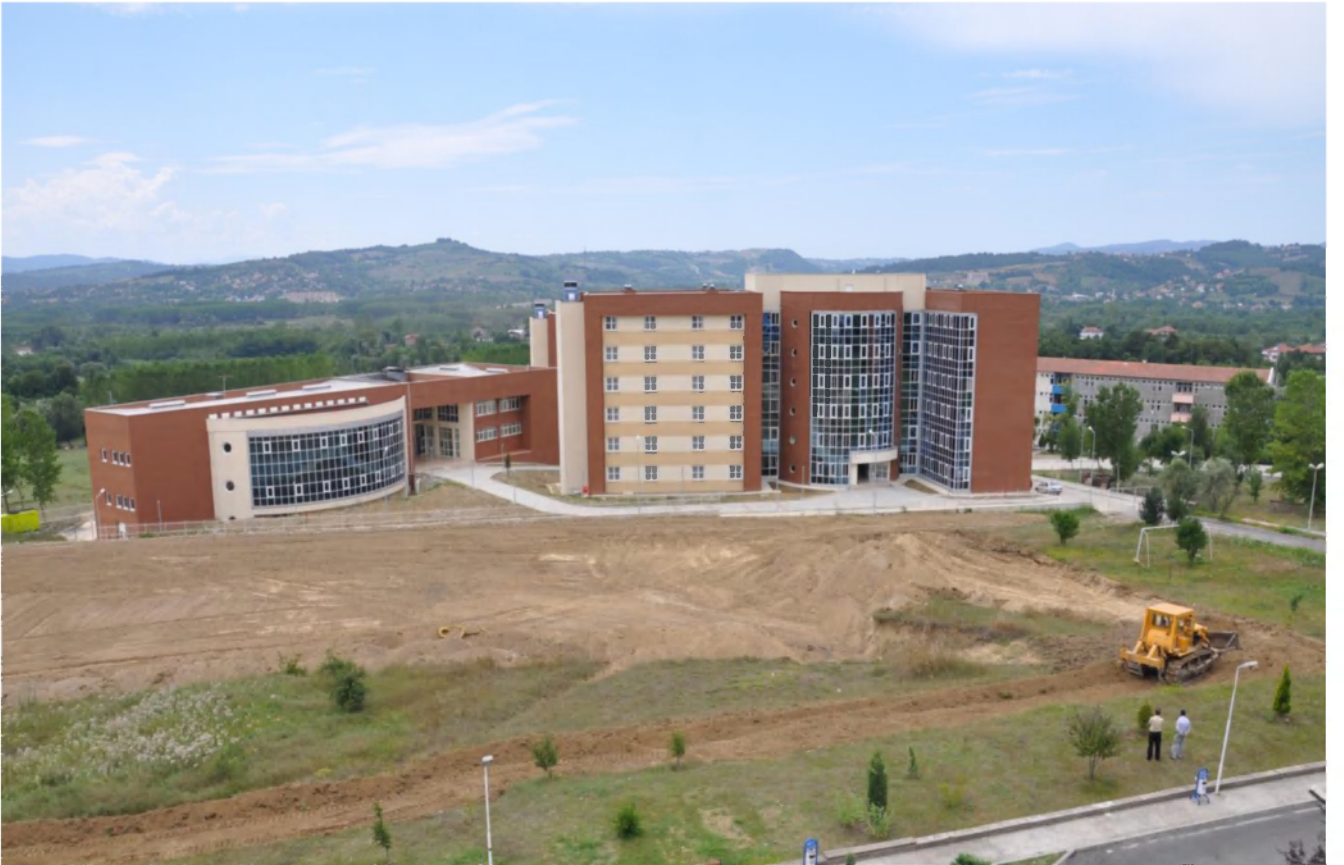
Sentetik Çim Saha Yapım İşİ
