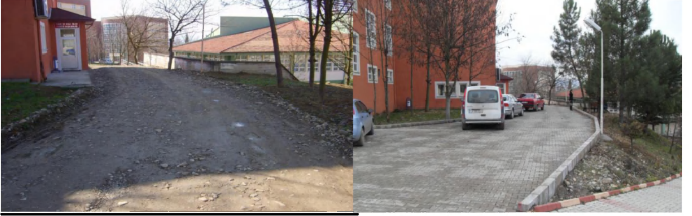
Kampüs İçi Kaldırım ve Kilitli Parke Yapım İşi
