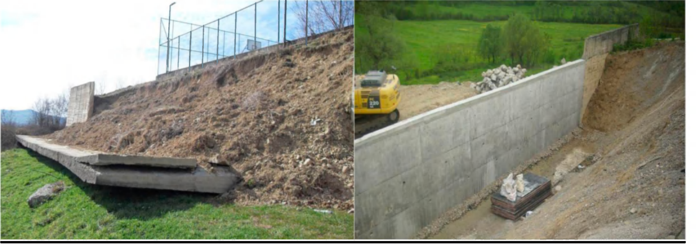
İstinad Duvarı Yapım İşi
