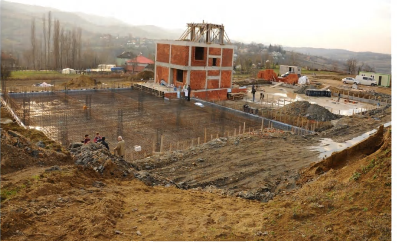
Merkezi Araştırma Laboratuvarı Yapım İşi
