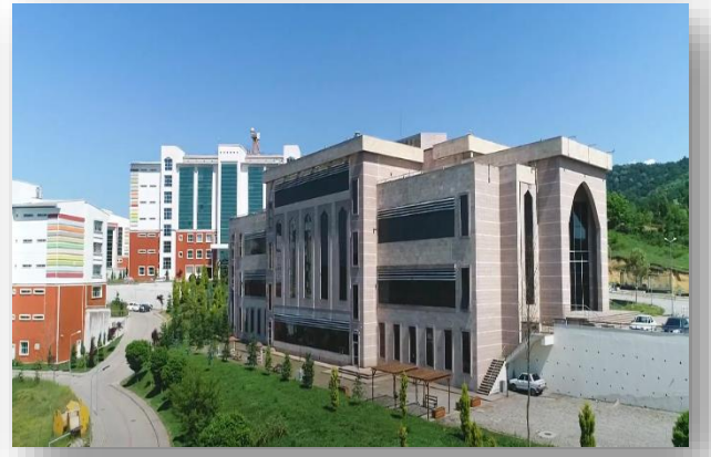
Sayısal Derslik Binası
