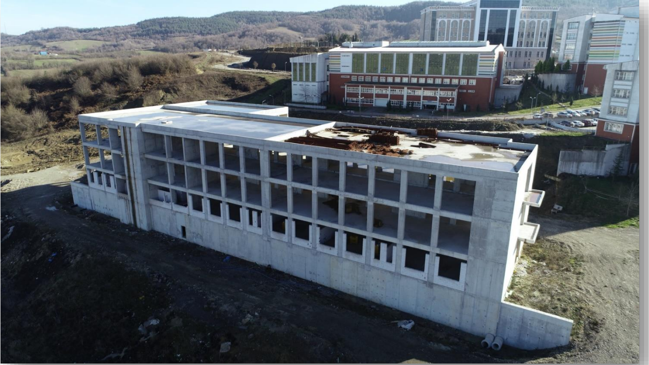
Yeni laboratuvar Binası
