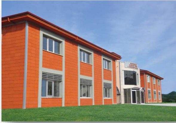
Merkezi Araştırma Laboratuvar Binası
