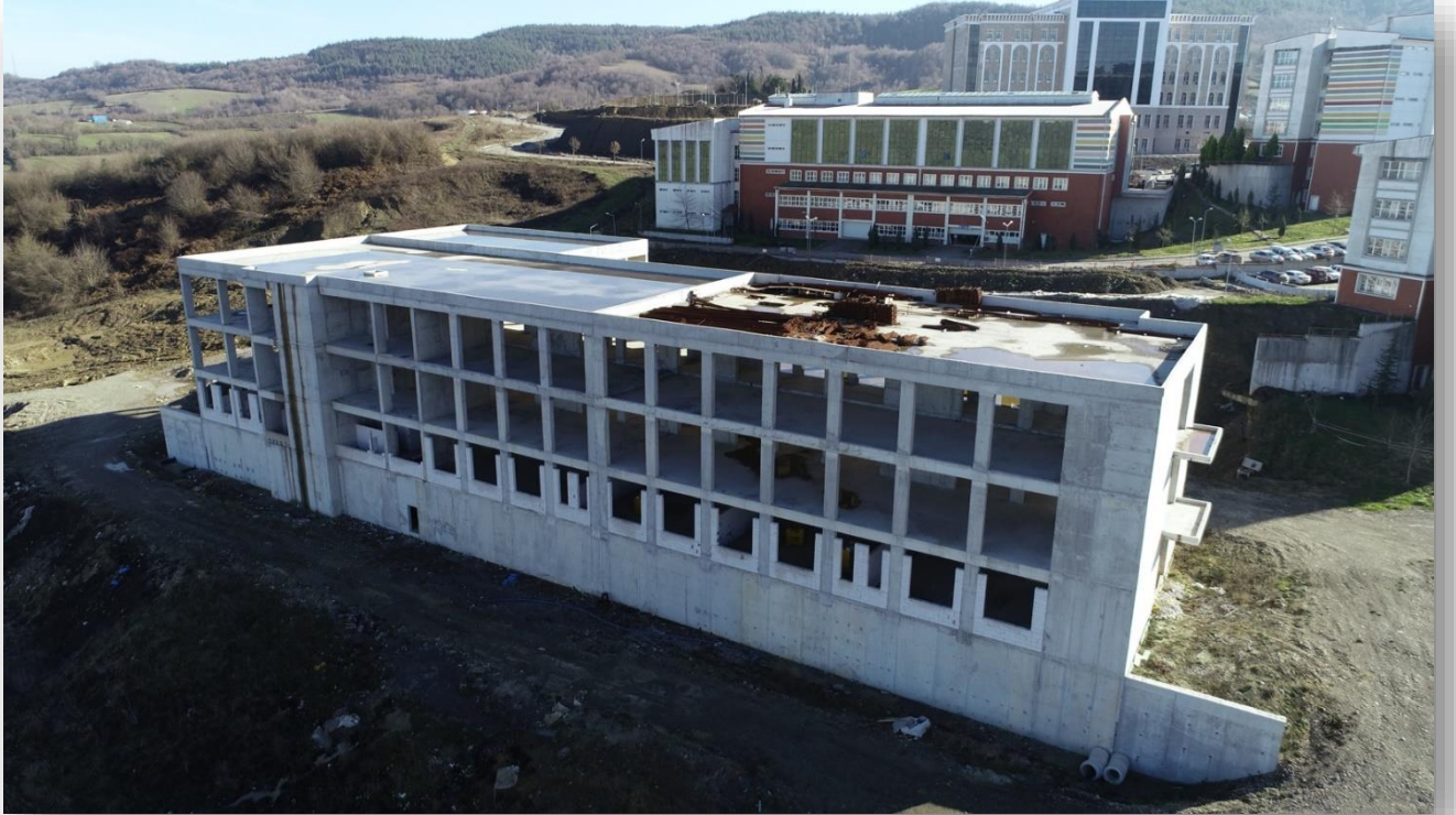
Yeni laboratuvar Binası
