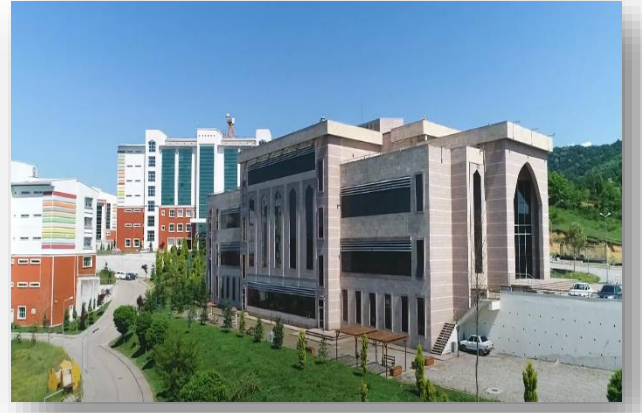
Sayısal Derslik Binası
