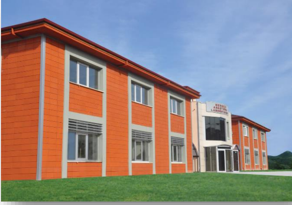
Merkezi Araştırma Laboratuvar Binası
