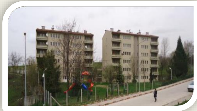
Türbe Yanı Mevkii Lojmanları (8 Adet Daire)
