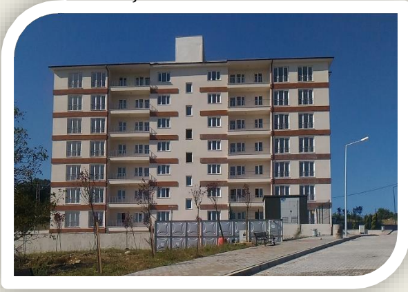
Kutlubey Kampüsü Lojmanları (30 Adet Daire)
