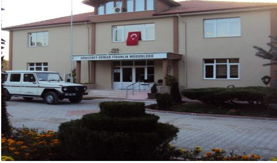
Şekil 1. Gökçebey Fidanlık Müdürlüğünün İdari Binası (URL-1, 2016).
