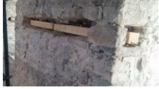
Emprenye ahşap hatılların uygulaması
