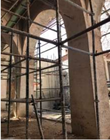
Horasan harcı ile sıvanmış sütunlar
