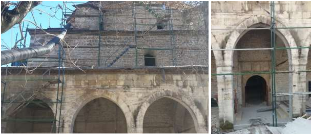
Şekil 3. Köprülü Mehmet Paşa Caminin renk değişimi olan yapısal elemanlarından bazı görünüm
