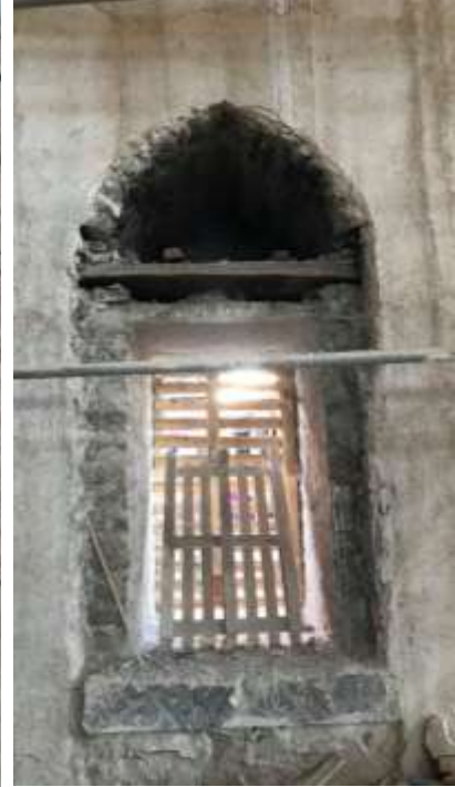
Horasan harcı ile sıva yapılması
