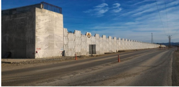
Şekil 1. Şerit donatılı toprakarme duvar yapımı (Kutlubeyazıcılar – Bartin)
