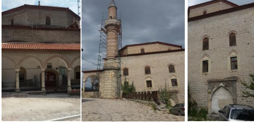
Şekil 1. Dağdelen caminin kuzey ve batı cephelerinden görünüm
