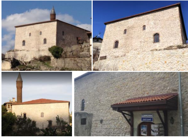
Şekil 4. Eski caminin cephelerinden bazı görüntümler
