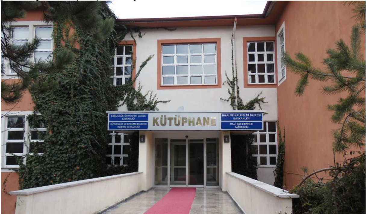
Şekil 7. Ağdacı Yerleşkesi Şube Kütüphanesi
