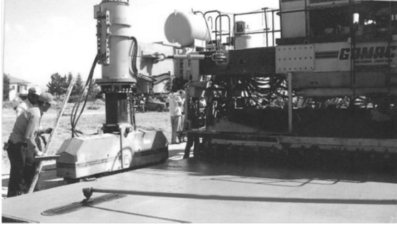
Finişerin arkasından kalıplanmış olarak çıkan beton yüzeyinin işçiler tarafından düzeltilmesi
