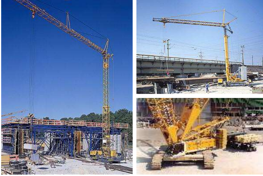
Foto.3.14. Paletler üzerinde hareket eden kule vinçler
