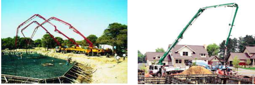
Foto. 3.27. Beton pompalarının çalışmasına ilişkin görüntüler
