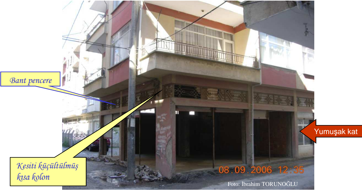
Yumuşak kat örneği: Hata üstüne hata!
