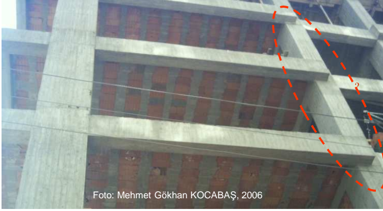
Kirişler kolona yapıştırılmış
