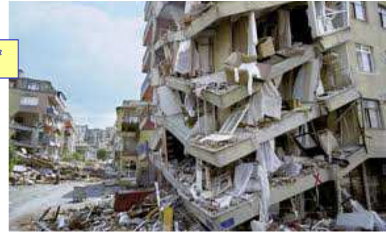
Köşe kolon hasarı
