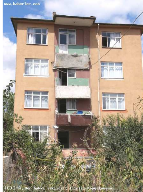
Samsun, 03.09.2006: Gelin uğurlamak için balkonlara çok sayıda insan yığılınca çöktü. 2 can kaybı, 16 yaralı (Fotoğrafların kullanım izni İhlas Haber Ajansından alınmıştır. 06.09.2006 Mert BALÇIK).
