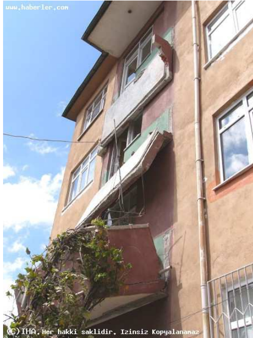
Samsun, 03.09.2006: Gelin uğurlamak için balkonlara çok sayıda insan yığılınca çöktü. 2 can kaybı, 16 yaralı (Fotoğrafların kullanım izni İhlas Haber Ajansından alınmıştır. 06.09.2006 Mert BALÇIK).
