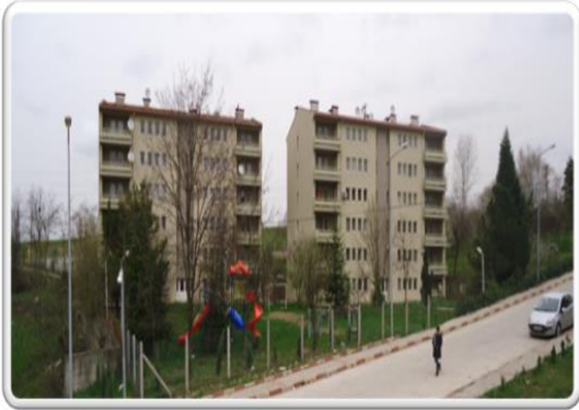
Ağdacı Kampüsü Lojmanları (A ve B Blok 24 Adet Daire)
