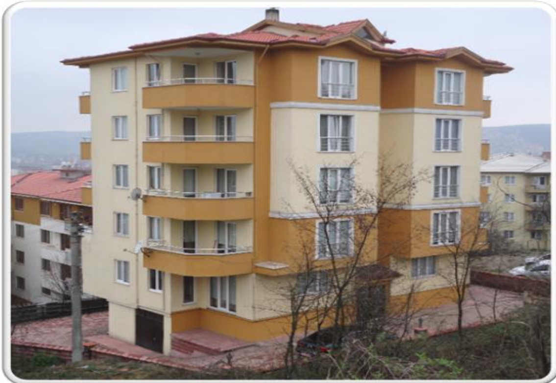
Türbe Yanı Mevkii Lojmanları (8 Adet Daire)
