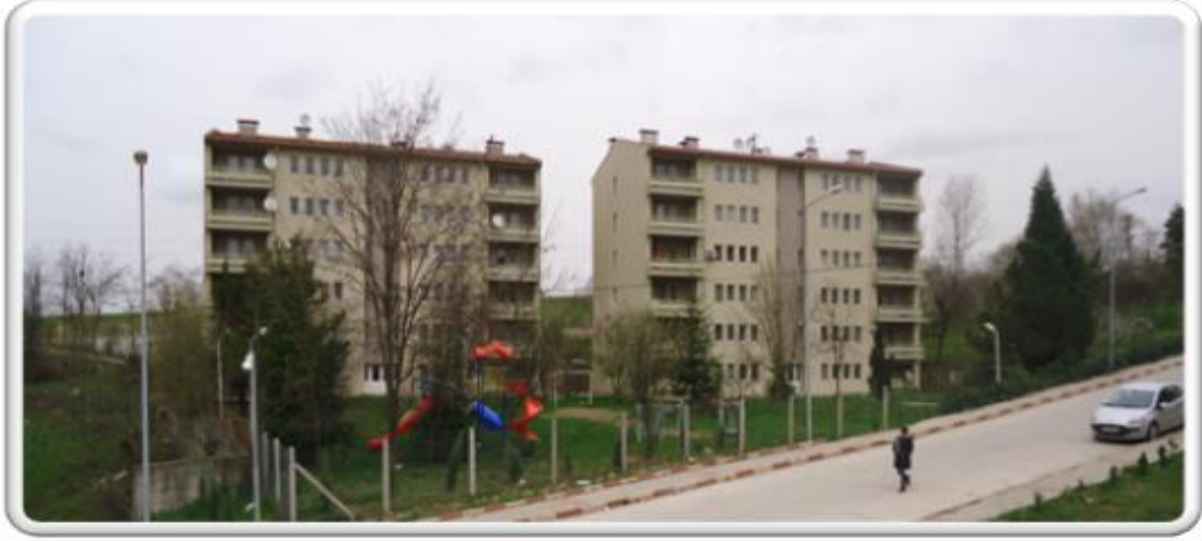
Ağdacı Kampüsü Lojmanları (A ve B Blok 24 Daire)
