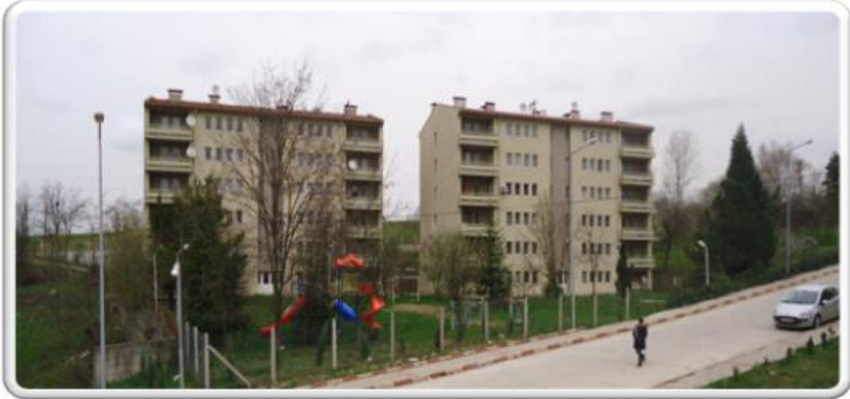
Ağdacı Kampüsü Lojmanları (A ve B Blok 24 Daire)
