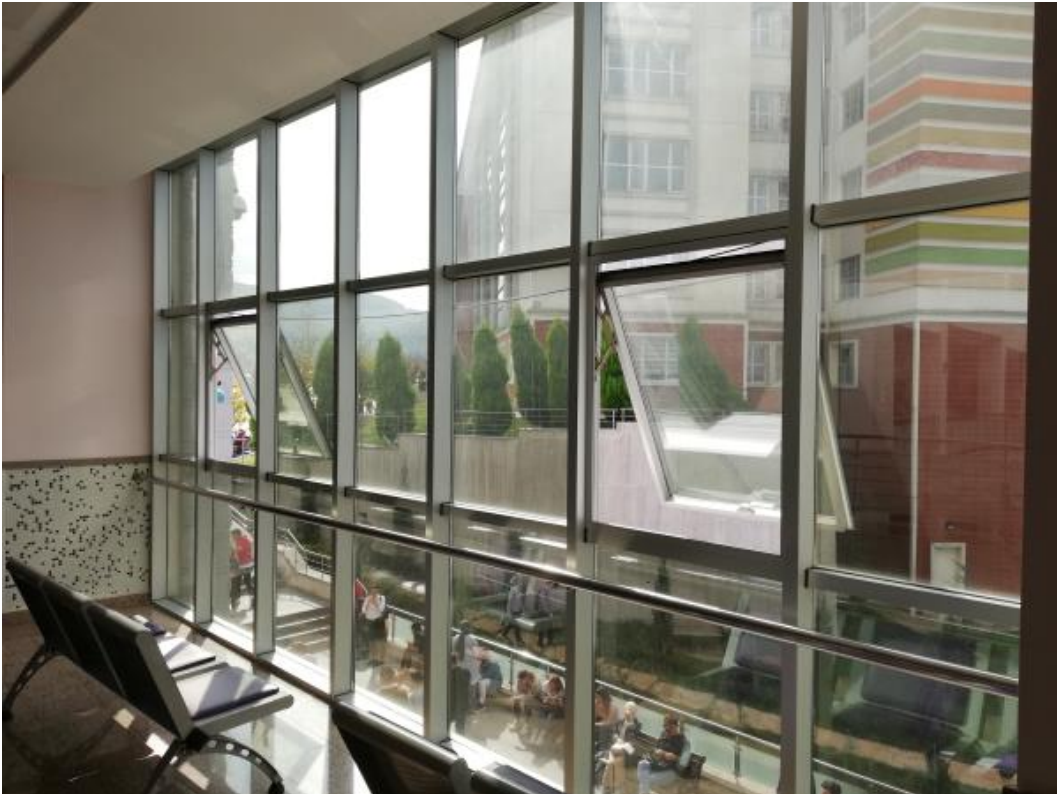
Natural ventilation (Sözel Derslik in Kutlubey Campus)
