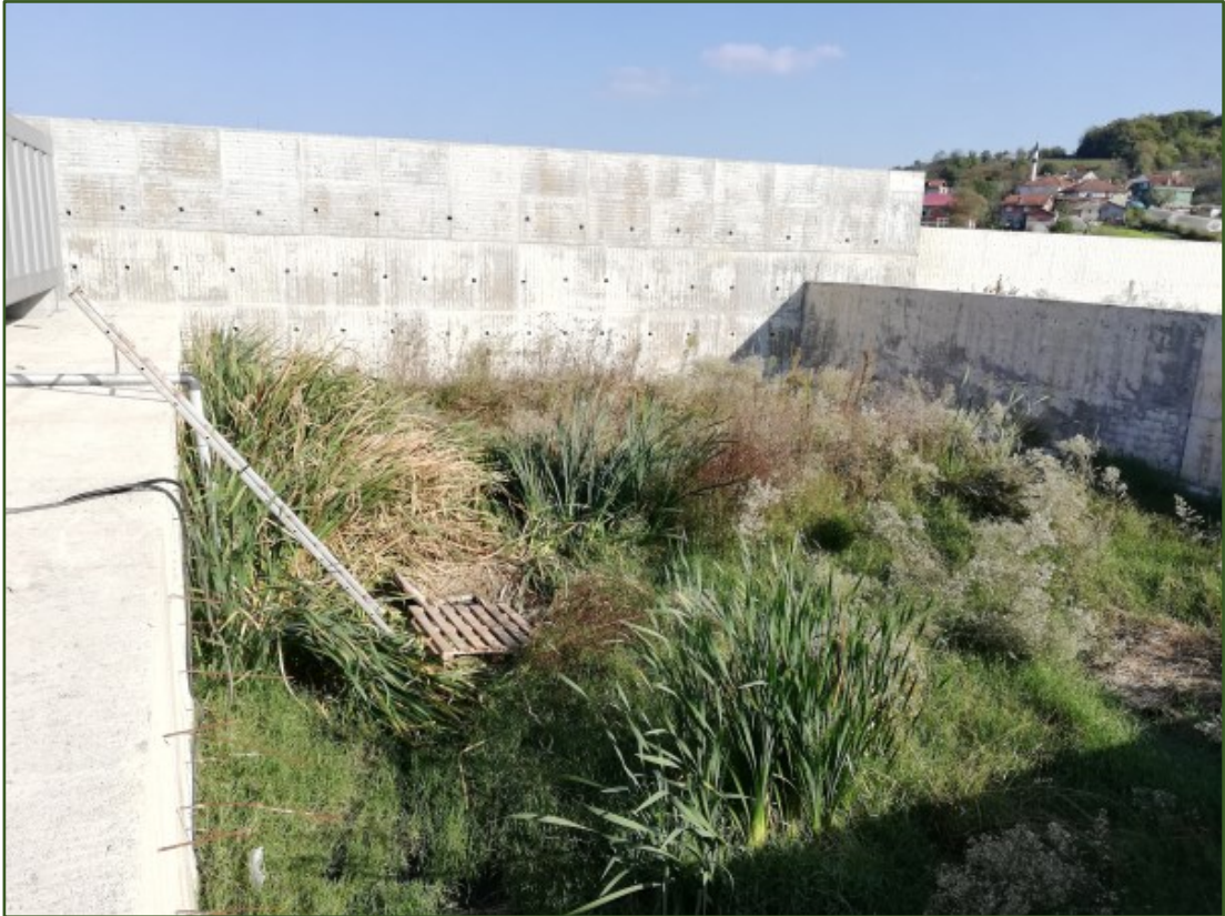
Kutlubey Kampüsü Arıtma Sistemi
