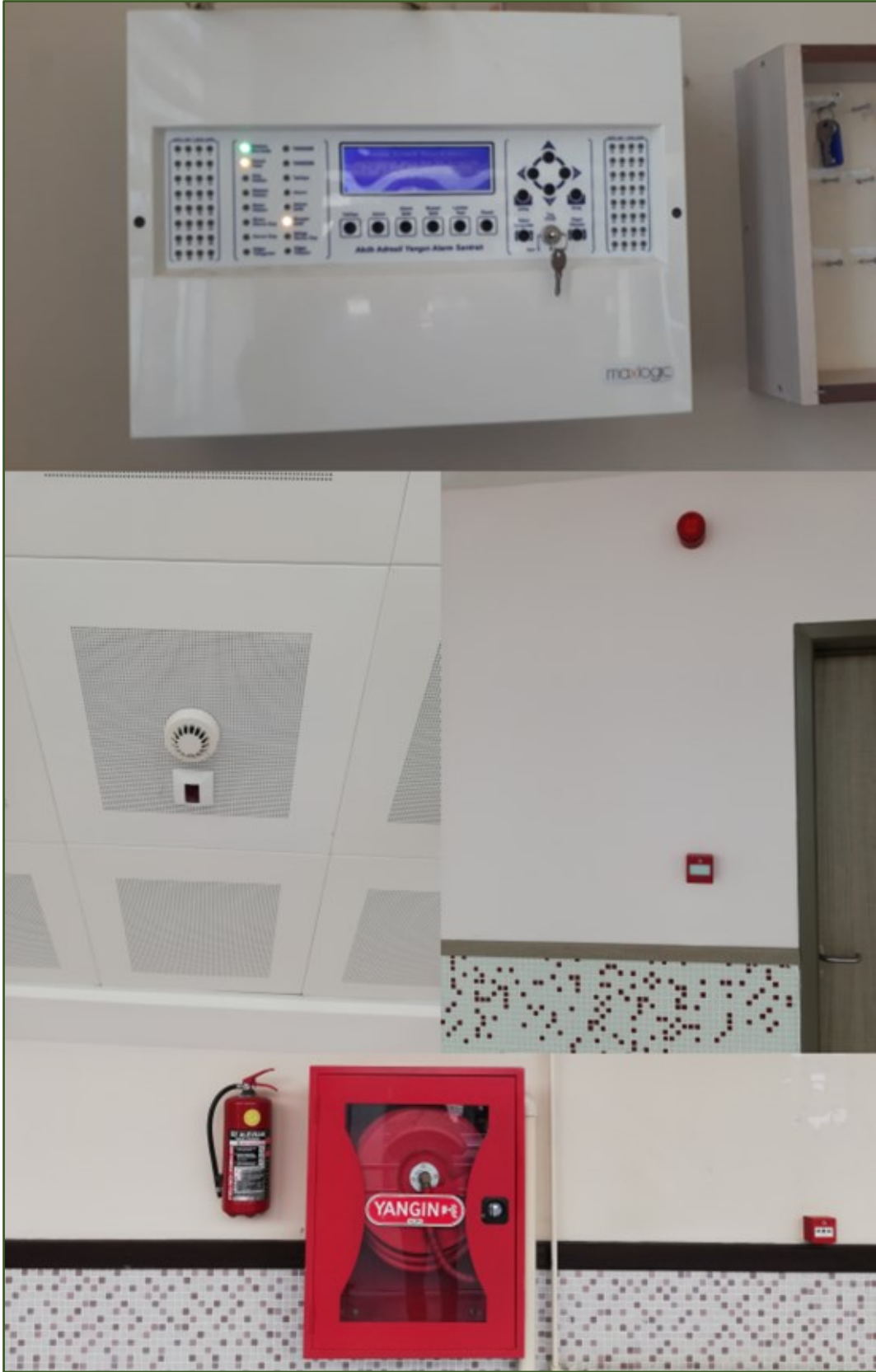
Yangın Alarm Sistemleri ve Yangın Söndürme Ekipmanları
