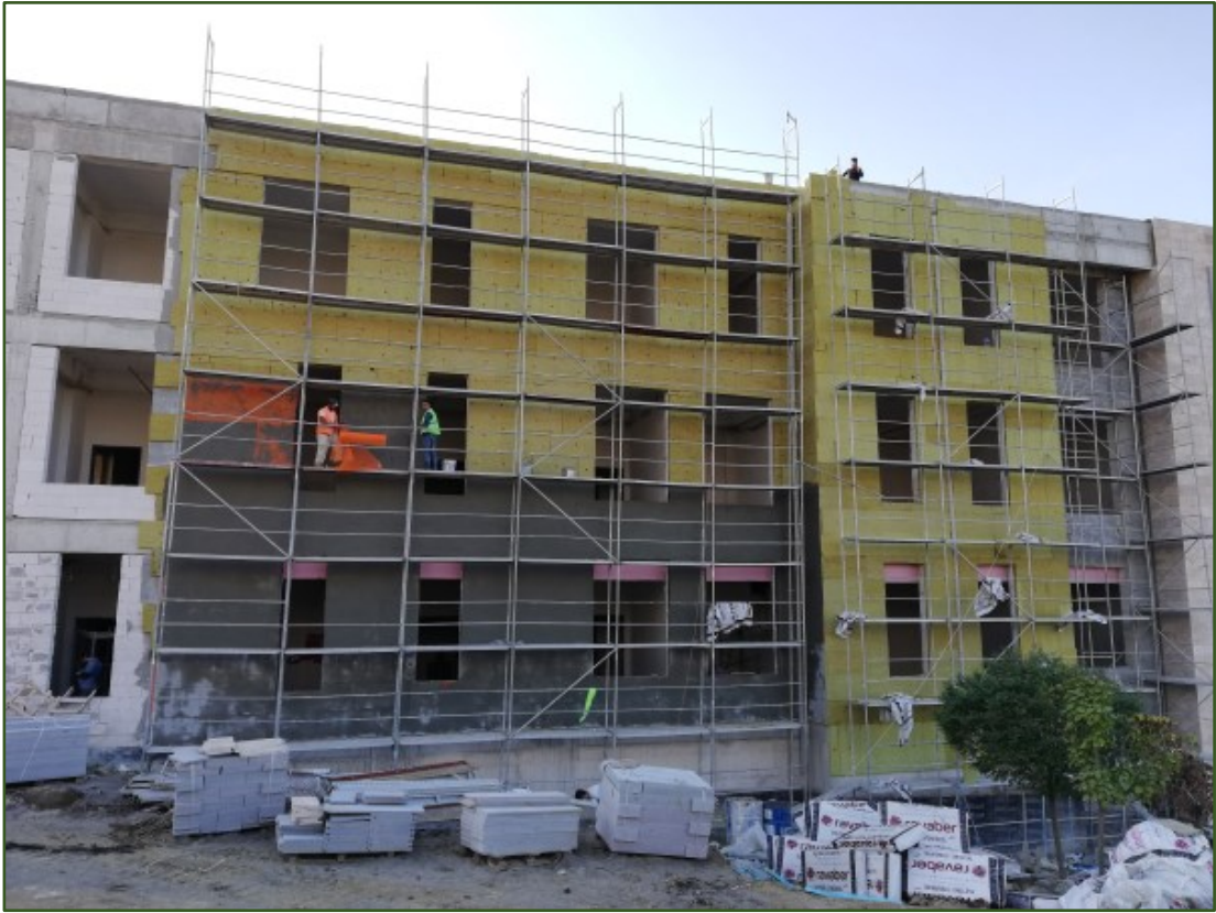
Kutlubey Kampüsünde yeni inşa edilen binalar yalıtımlı olarak yapılmıştır.
