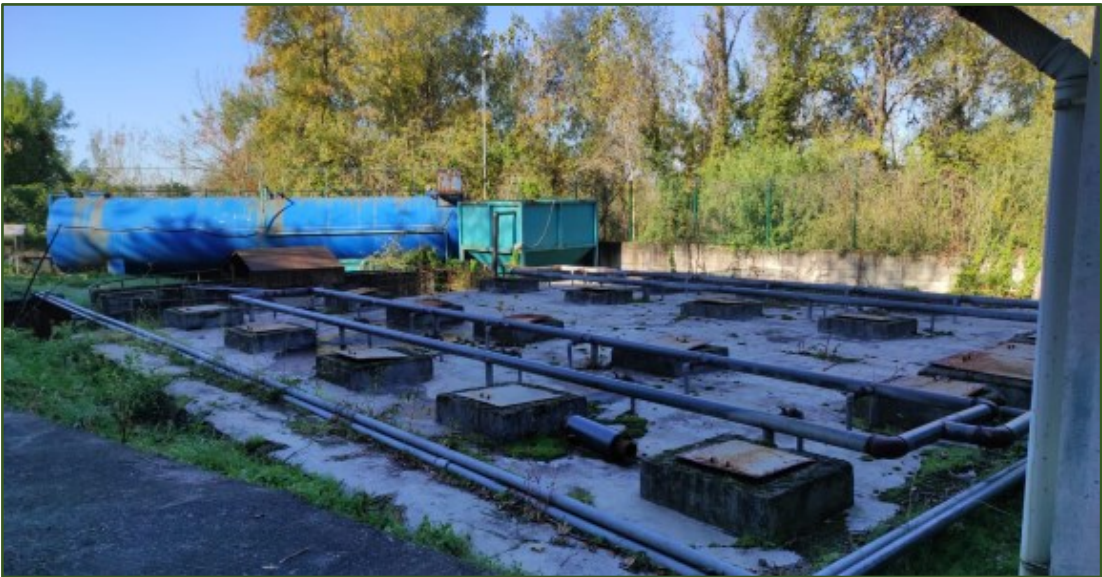
Ağdacı Kampüsü Arıtma Tesisi
