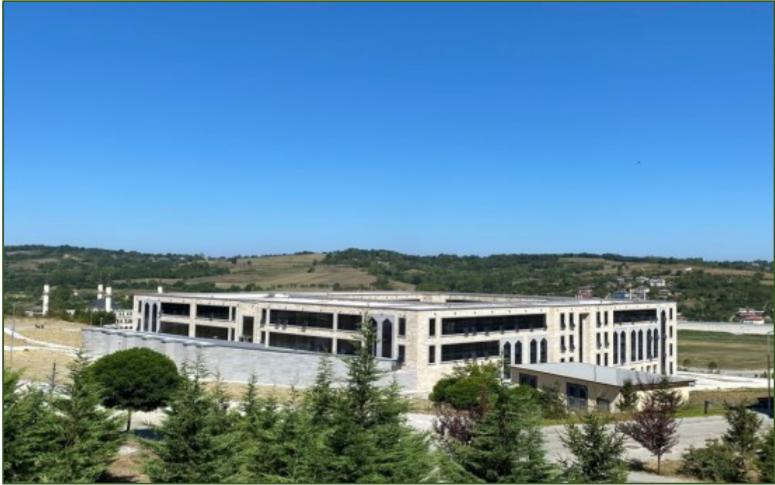
Kutlubey Yerleşkesinde yapımı bitirilen yeni derslik binası 2020 yılında hizmete alınmıştır.
