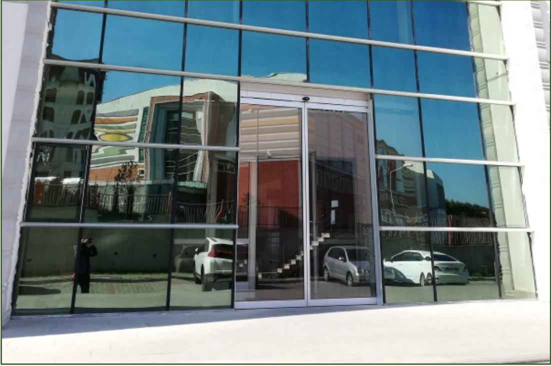
Sensörlü Otomatik Kapı Sistemleri ve güneş kontrollü camlar.
