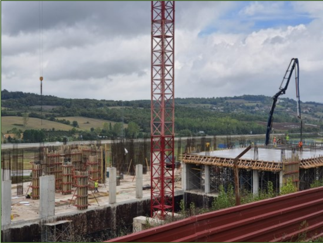
Kutlubey Yerleşkesine inşa edilen Rektörlük ve Merkezi Araştırma Laboratuvarlarının yapım süreçleri devam etmektedir.
