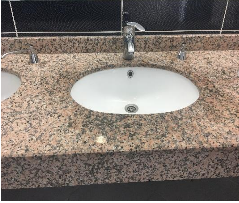
Üniversitemizde kullanılan musluklar debi düşürücü özellikte olup, su tasarrufu yapılmasında yardımcı olmaktadır.
