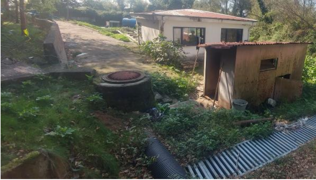
Ağdacı Kampüsü Arıtma Tesisi
