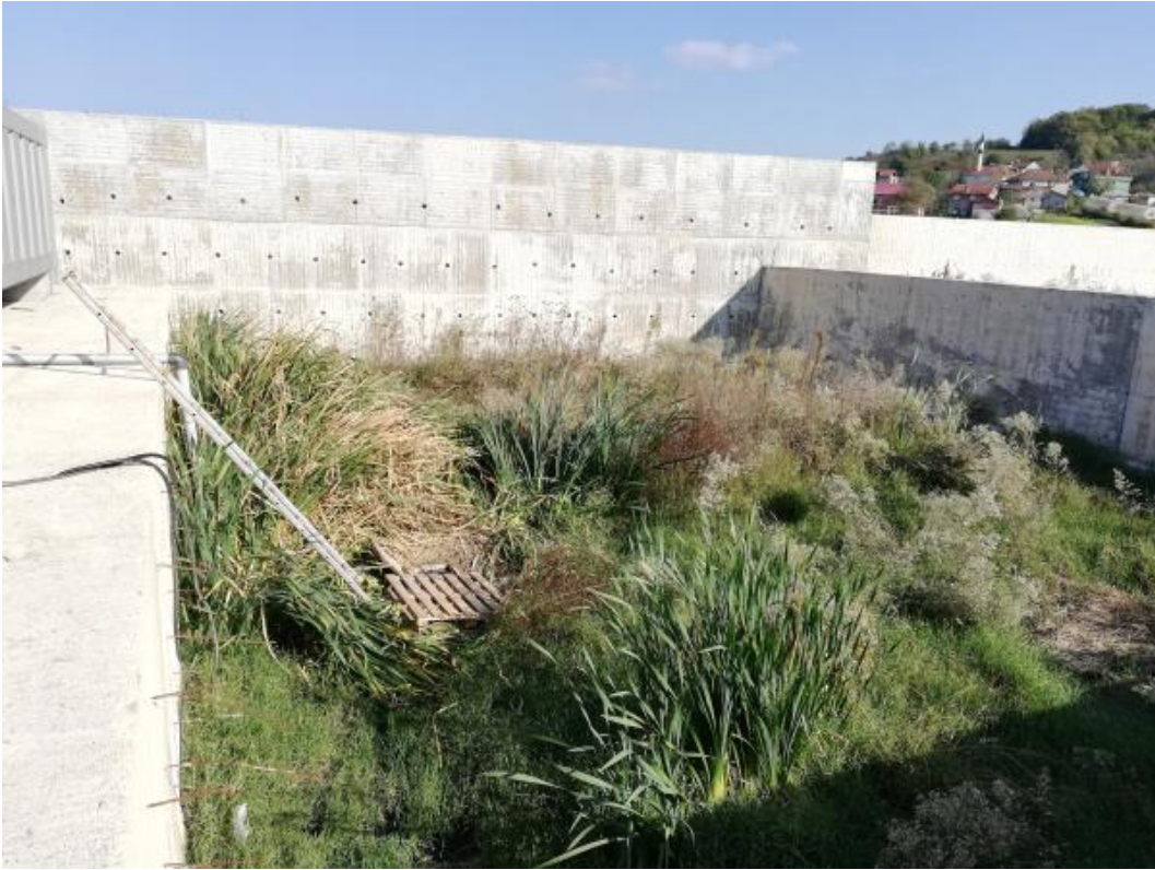
Kutlubey Kampüsü Paket Arıtma Sistemi
