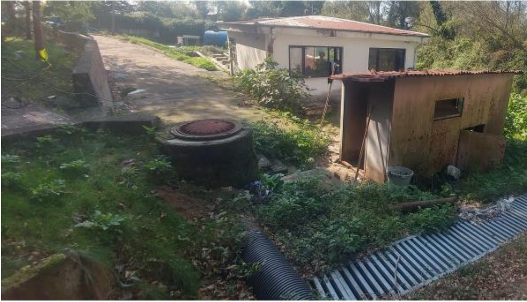
Ağdacı Kampüsü Arıtma Tesisi
