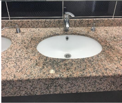
1. Kampüs Binalarında Su Verimli Cihazların Kullanımı (Debi Düşürücü)
